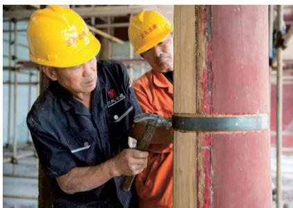
挖补、包箍南庑殿槽朽梁柱
