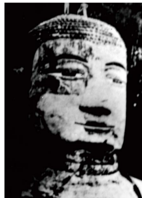
第二次维修的大佛 (1929—1934年)
