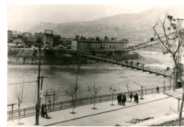
70年代“三线”建设时期修建在金口河城区的工农兵大桥远景
