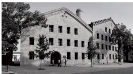
1940年建成的永利川厂自备电厂，内装气发电机功率为600KW
