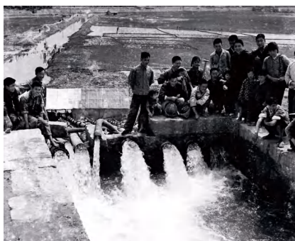
1973年的夹江县复兴公社黄土大队的三皇庙提灌站，通过机电设备把东风堰水提灌到丘陵地区抗旱 张致忠/摄
