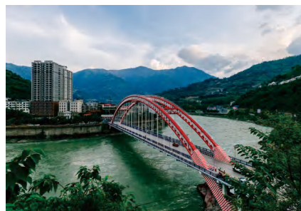
1999年建成的金口河大渡河大桥
