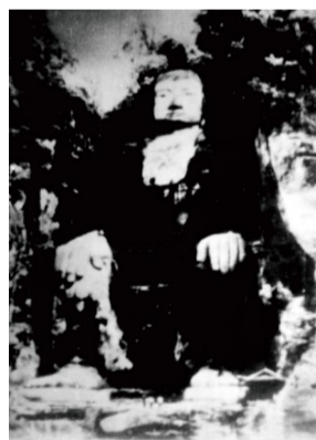
第四次维修的大佛 (1972—1975年)
