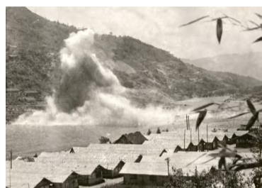
1966年3月15日，龚嘴电站开工第一炮
