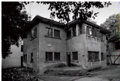
1939年建成的永利川厂创始人范旭东先生办公和居住的1号公馆楼
