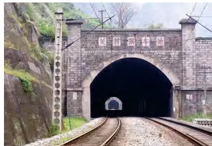
成昆线第二长隧道-关村坝隧道
