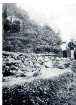
乐西抗战公路施工现场照片
