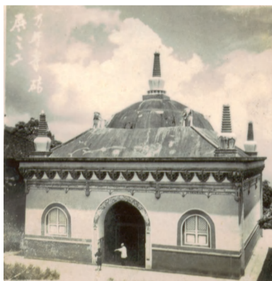
民国时期的峨眉山万年寺无梁砖殿
