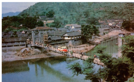
1969年11月，马边县城北门铁索吊桥建成投入使用
