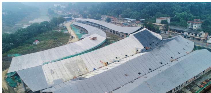
项目的单体建筑2、3、4号楼航拍
