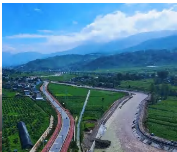
凉山州越西县翰林大道
