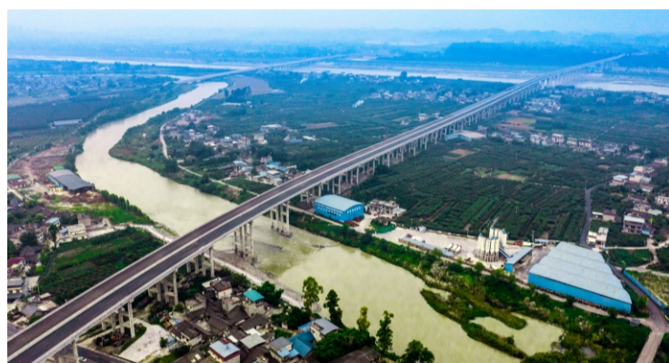
图为乐西高速公路（乐马段）控制性工程大渡河特大桥
