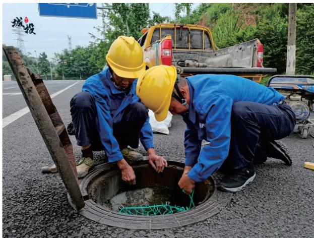
更换，同时在井内安装防坠网。工作人员每完成一个防坠网，都会亲身试踩检验，确保安装牢固，有效避免下水井“坑人”。
