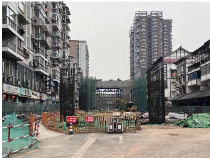
图为施工现场
